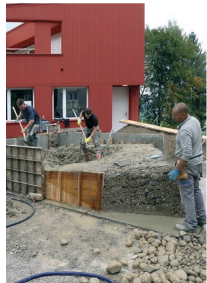
Krönender Abschluss der Bauarbeiten in Trogen: Der Brunnen vor dem Haus Fontana
